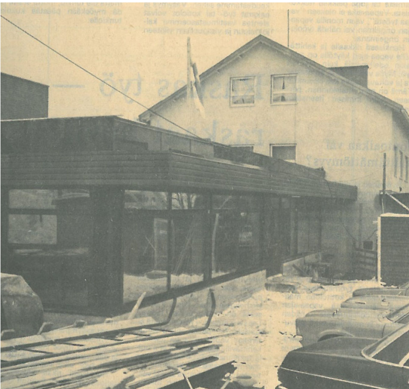
1978 pankkia laajennettiin. Kuva rakennustyömaasta julkaistiin vuonna 1978 Valkeakosken Sanomissa. Lähde: Sydän-Hämeen Lehti.
