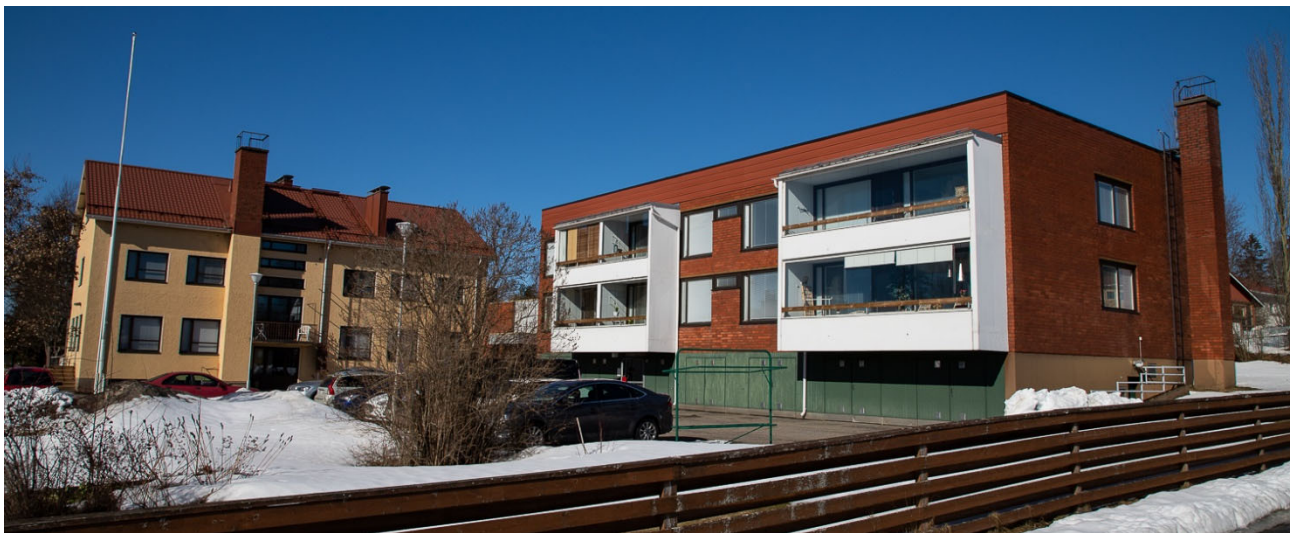
Osuuspankin kiinteistön rakennus koostuu kolmesta eri-ikäisestä rakennusosasta. Pihan puolella on 1970 rakennettu asuinkerrostalo.
