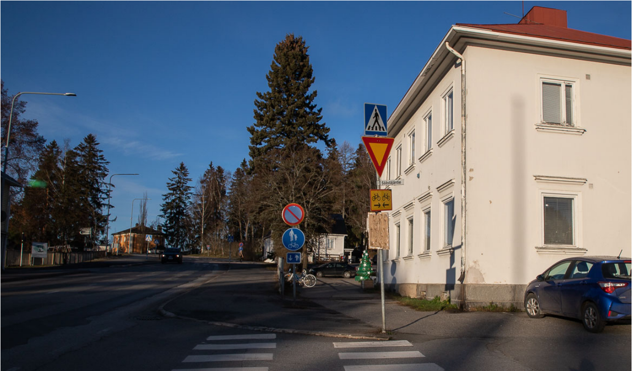
Onkkaalantietä Säästöpankin rakennuksen kohdalla. Katualuetta on korotettu tien loiventamiseksi. Rakennukset ja niiden piha-alueet ovat jääneet tienpintaa alemmaksi.
