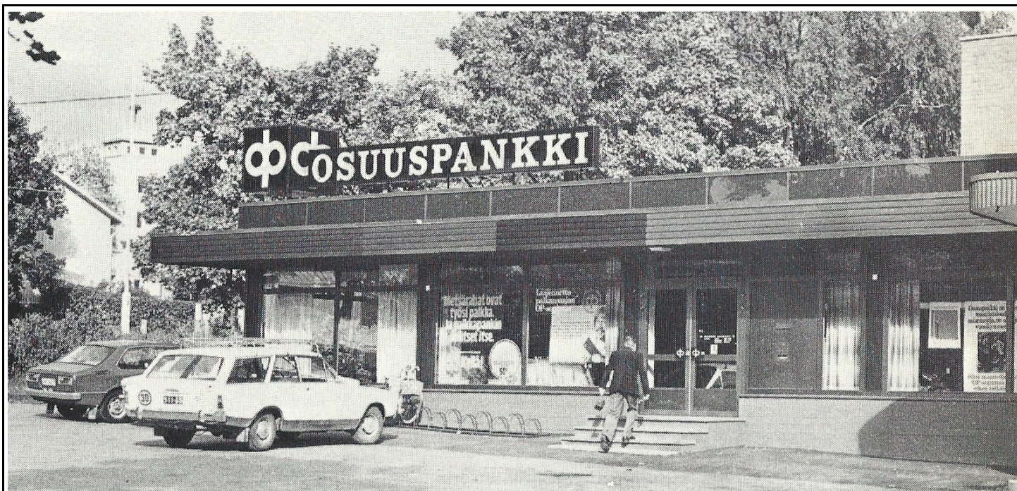
Pälkäneen Osuuspankin laajennusosa vuodelta 1978. Lähde: Pälkäne. Pälkäneen kunta. Pälkäne-seura. Valkeakoski 1978.
