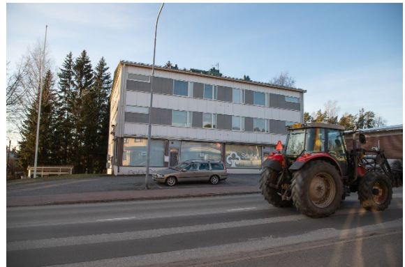
Korttelissa 77 sijaitseva asuin- ja liikeyrakenus, jonka katutasossa on kiinteistöväälitystoimisto ja tyhjillään oleva liikeyrakenus. Rakennus on rakennettu vuonna 1962.
