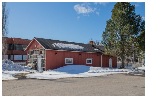
Säästäjätien varrella on ravintolan sisäpihalla talousrakenus, jossa on tilat kesäravintolaa ja varastoa varten.
