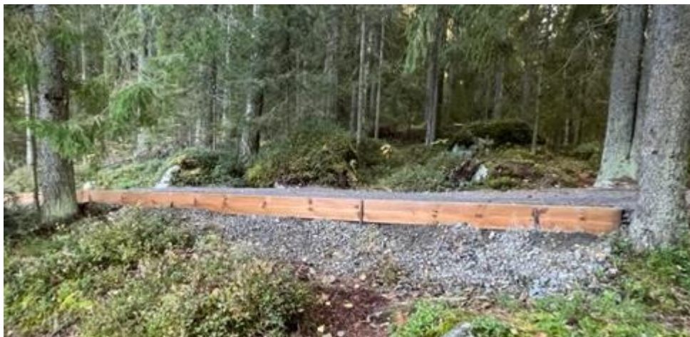
Esimerkkikuva lankkustopparista, lankun päältä puuttuu kuvassa jalkalista.
