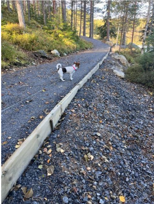
Esimerkkikuva lankkustopparista. Stoppari estää maa-aineksen valumisen, sekä helpottaa poikittaiskaltevuuden tasaamista.
