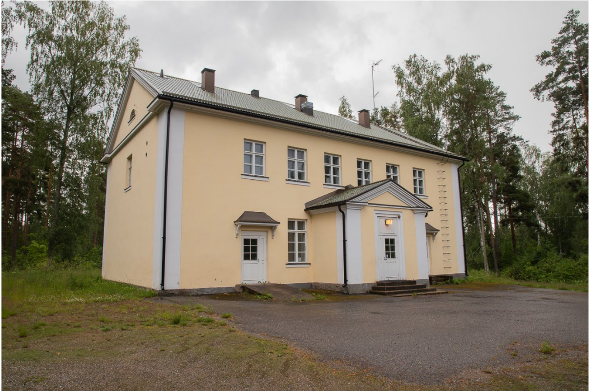
Harhalan koulun päärakennus.
