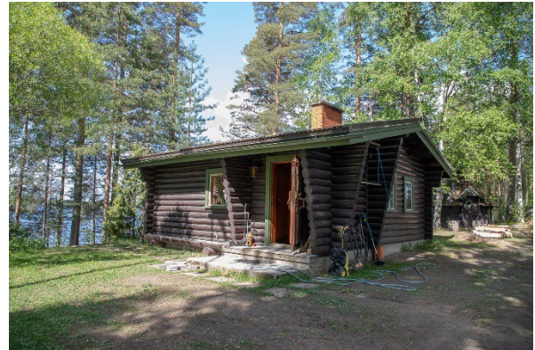
Vuonna 1970 rakennettu sauna, jonka kerrosala on 22 m 2 .
