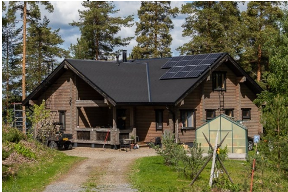
Vuonna 2013 rakennettu ympärivuotiseen käyttöön soveltuva vapaa-ajan asuinrakennus, jonka kerrosala on 138 m 2 .
